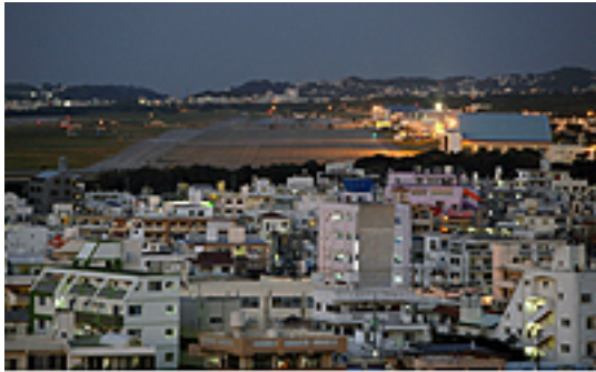
住宅街に隣接する米海兵隊普天間飛行場
