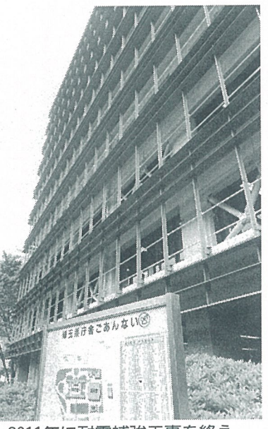
2011年に耐震補強工事を終えた埼玉県庁
